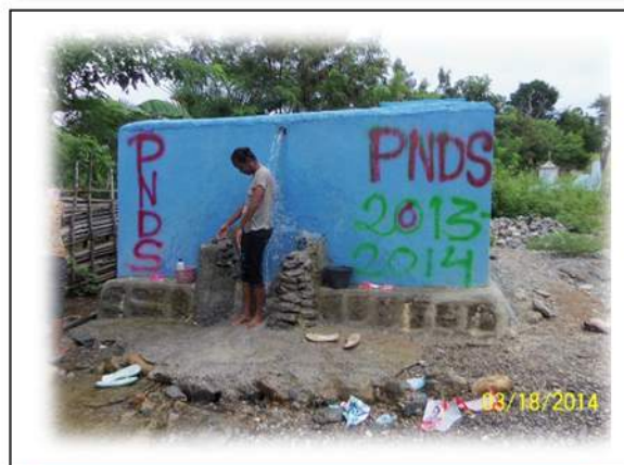
REHABILITASAUN BE'E MOS HATUCONA LAKUMESAK, MANATUTO VALOR ORSAMENTU : $ 8,227.04
