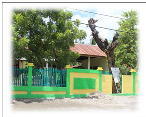
KONSTRUSAUN MORU HALEU SEDE SUCU VALOR ORSAMENTU : $ 17,256.00
