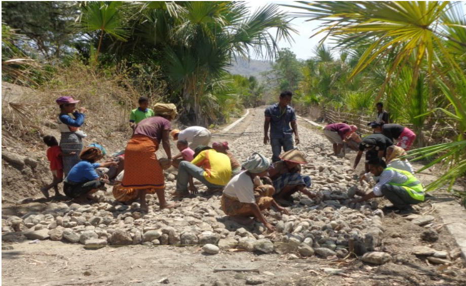
Komunidade iha suco Lifau Distritu Oequsse serbisu hamutuk hodi implementa projetu Rehabilitas Istrada iha sira nia suku.
