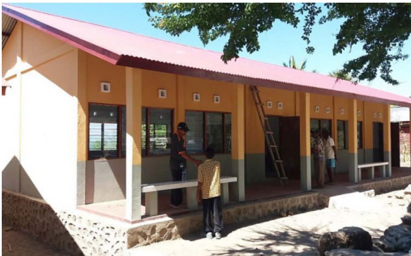
Projeitu Konstrusaun Aumenta Sala Eskola Primaria Iha Suku Maquili, Postu Administrativu Atauro, Municipiu Dili. Ho total orsamentu $42,953.56
