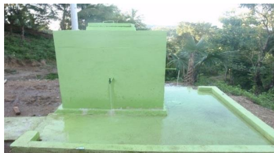
Konstrusaun Be'e Mos Suku Dau Udu – Postu Administrativu Cailaco Municipio Maliana ho Total Orsamentu $ 11,073.19
