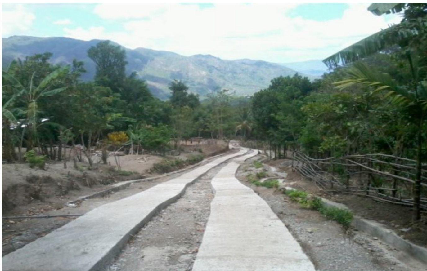
Rehabilitasaun Estrada Lokal iha suku Nipane Postu Administrativo Pantemacasar-Oecusse ho total orsamentu $ 44,250.00
