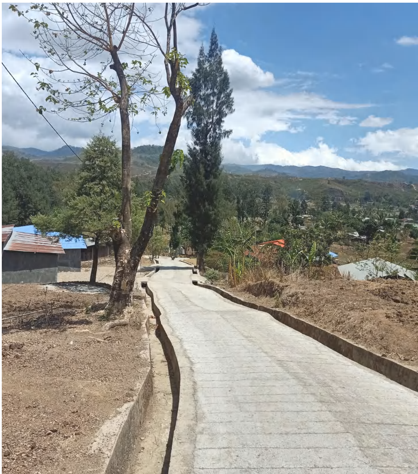
Progresu Fiziku ba Projetu Rehabilitasaun Estrada Rabat Beton iha Suku Fahiria, Postu Administrativu Aileu Vila, Munisípiu Aileu.
