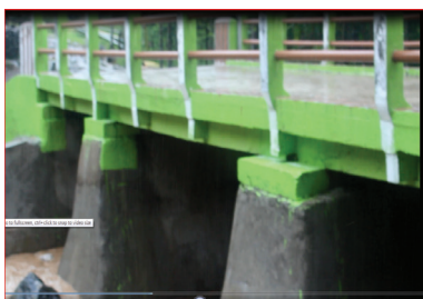
Konstrusaun Ponte Implementa liu husi serbisu hamutuk komunidade
